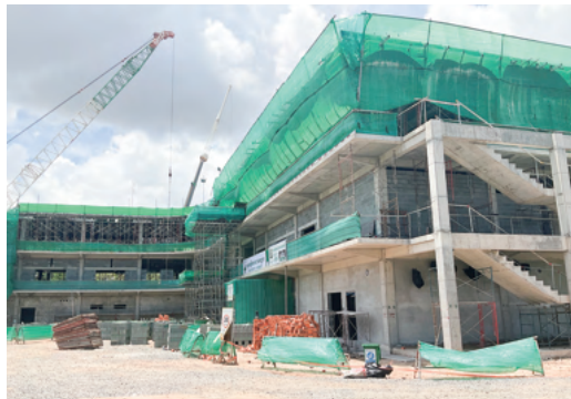
カンボジア新病院 建設中の様子
