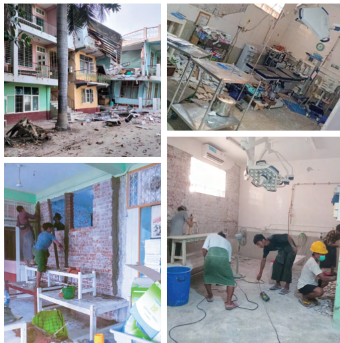
上段：発災直後の病院 下段：5月の修繕工事
